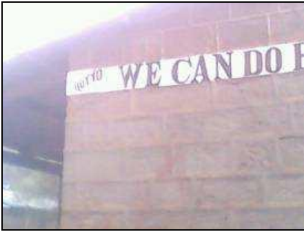
Le mur avant de commencer.
