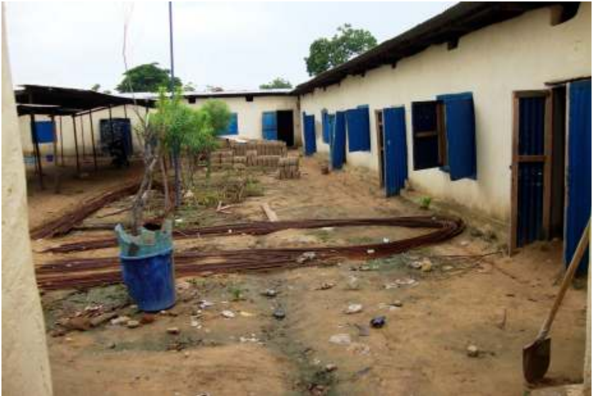
Le Lycée en réfection pour le lancement de l'année scolaire en cours.
